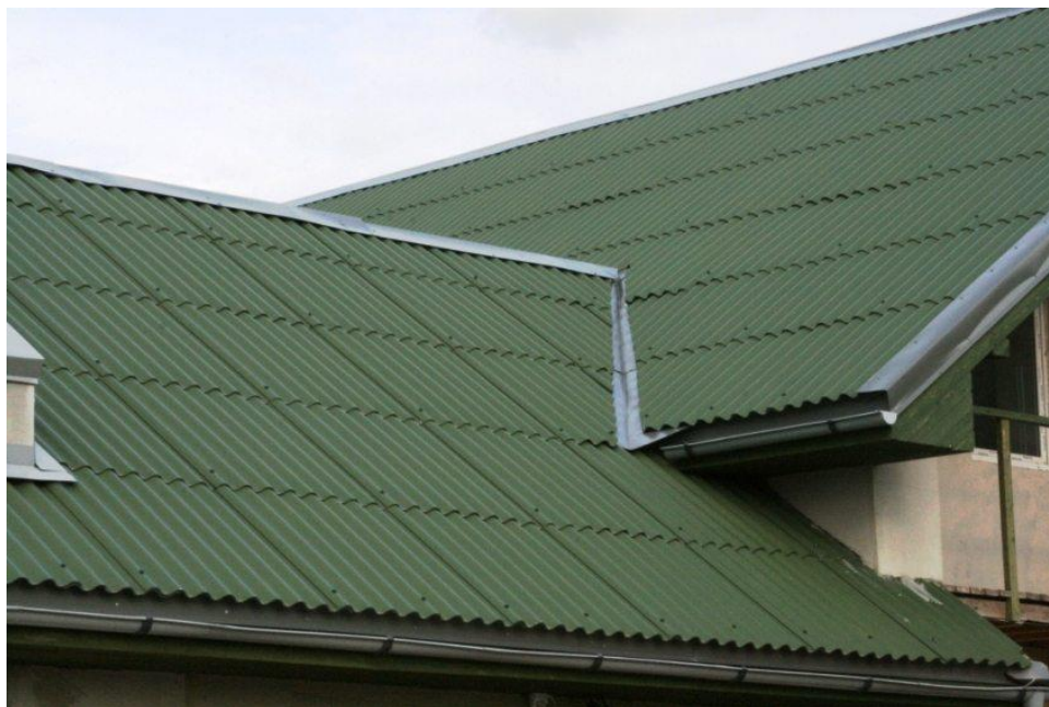
Пример обустройства кровли из шифера
