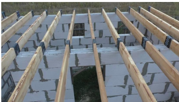
Гидроизоляция балок в опорных точках
