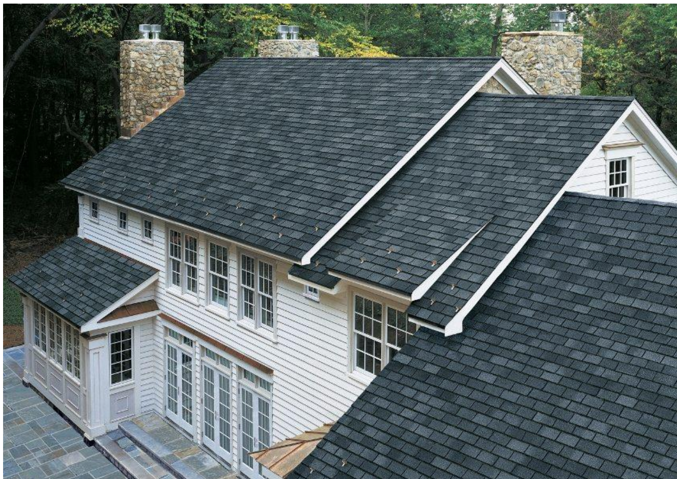
Крыша дома укрыта мягкой кровлей
