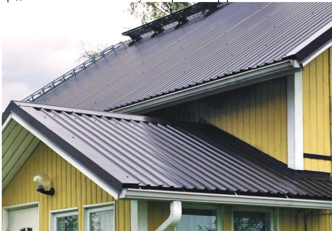
Крыша из профнастила
