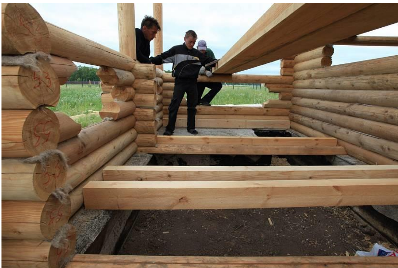
Балки перекрытия для пола 1 этажа
